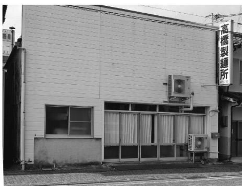
浜地区の五条通り沿いにある工場
